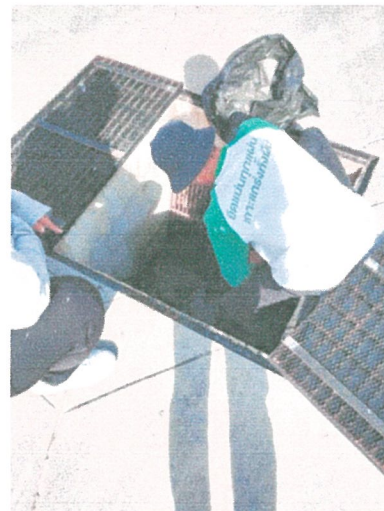
รูปภาพที่ 2.52 การขุดลอกตะกอนในรางระบายน้ำ
