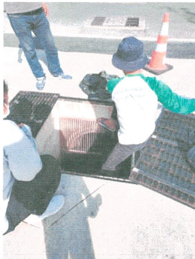
รูปภาพที่ 2.52 การขุดลอกตะกอนในรางระบายน้ำ
